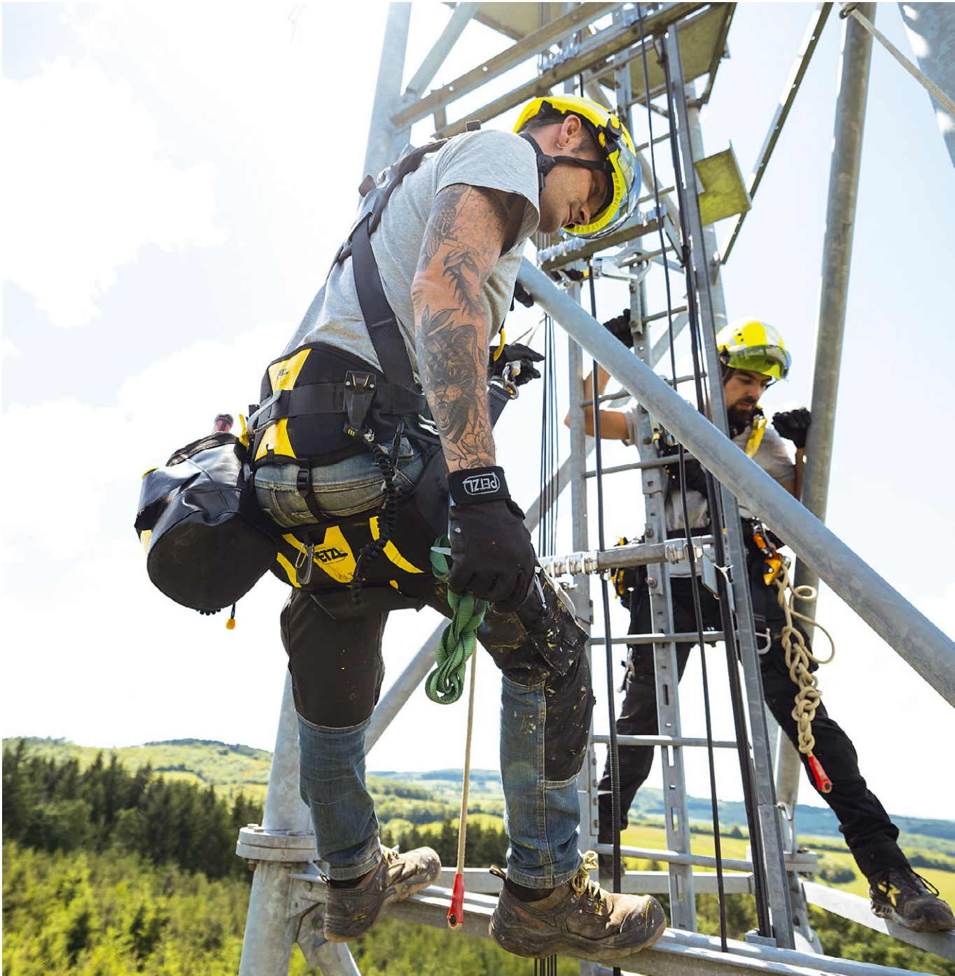
Para ajustarse mejor a la morfología de cada usuario, los arneses Petzl son regulables al nivel de la cintura, los hombros y los muslos. Están equipados con diferentes tipos de hebillas: Telecommunication tower maintenance, France. © 2025 Petzl Distribution - Vuedici.org - Everest - Axione
